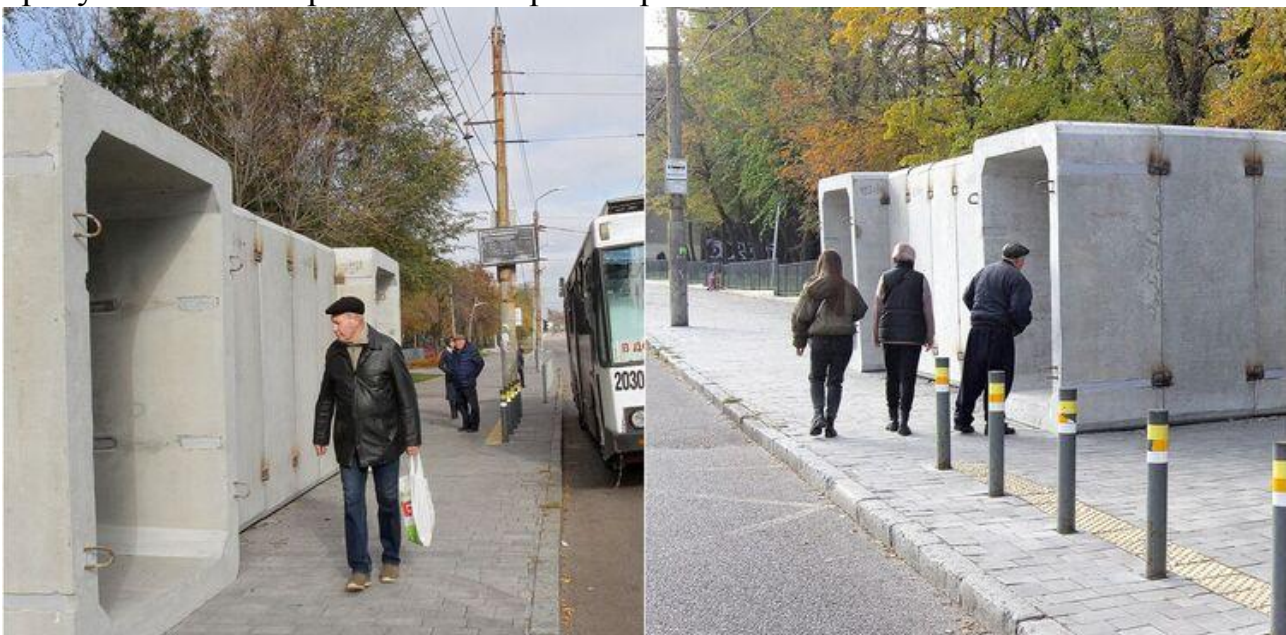
Рисунок 2. Вигляд «бетонної зупинки» – захисної споруди цивільного захисту [2].
