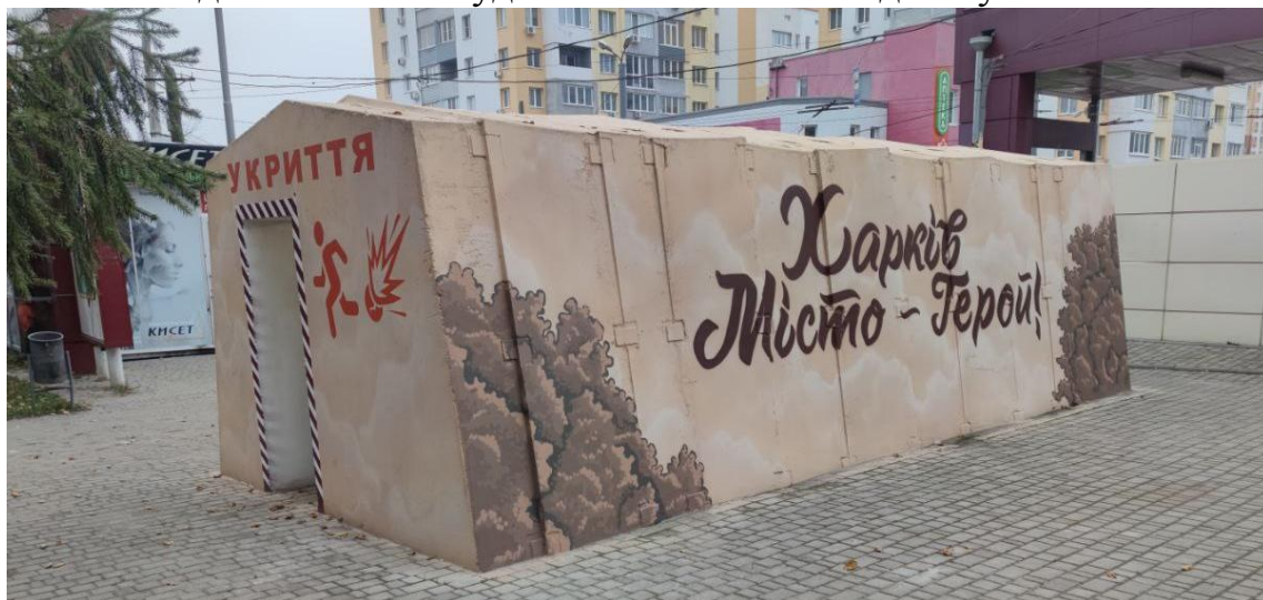
Рисунок 3. Вигляд «бетонної зупинки» у місті Харків
