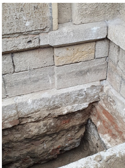
Foto 5. Analiza vizuală pentru identificarea rezistențelor, a structurii compozite a continuității Foto 6. Parament și prelevare de probe
