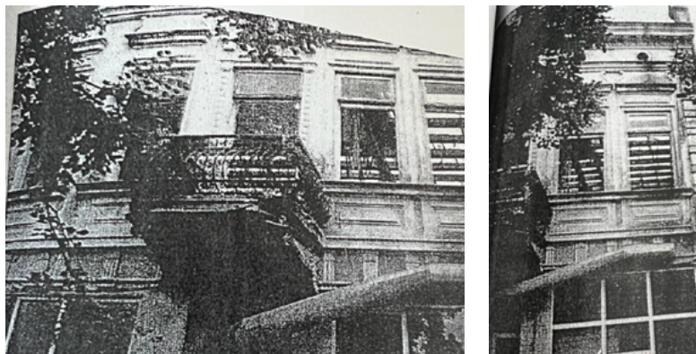
Foto 1,2. Fațadă principală, imobil aflat în ansamblul monument istoric și în zona de protecție a monumentului istoric clasat individual - anterior lucrărilor de restaurare. 1
