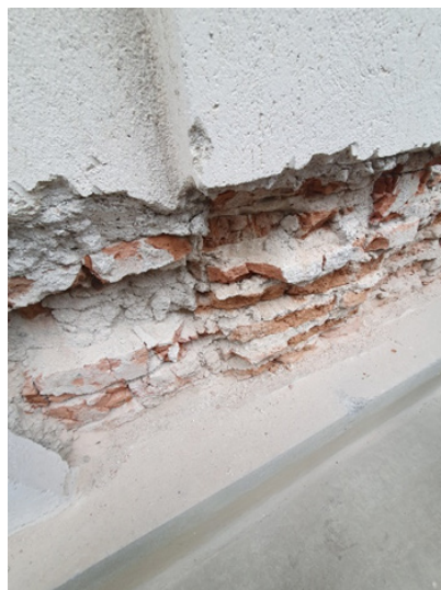
Foto 5. Analiza vizuală pentru identificarea rezistențelor, a structurii compozite a continuității Foto 6. Parament și prelevare de probe
