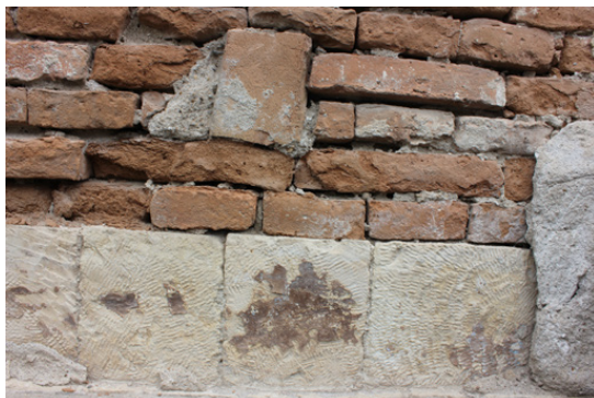
Foto 7. Zone decopertate pentru expertiza de parament
